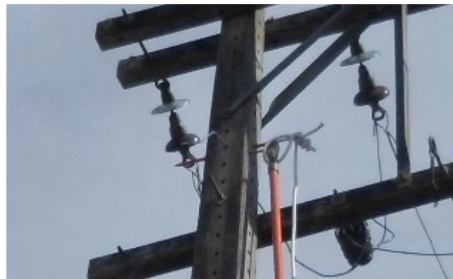
Figura 26 - Instalação do agulhão no poste
