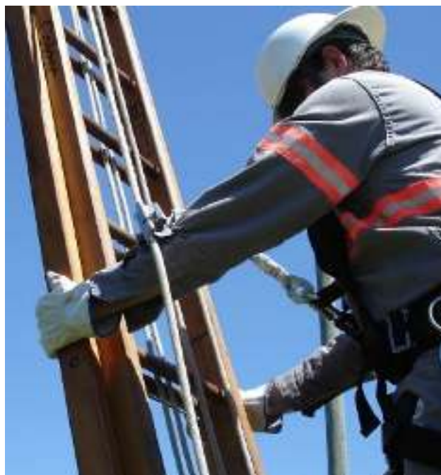
Figura 32 - Instalação do talabarte
