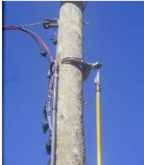
Figura 22 - Ancoragem da garra
