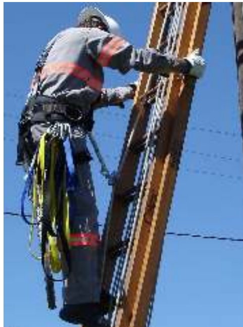
Figura 33 - Elevação do trava-quedas para iniciar a descida
