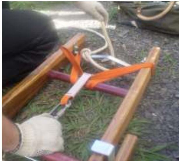
Figura 11 - Instalação do ponto de ancoragem
