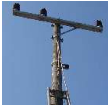
Figura 16 - Ancoragem na ferragem do poste
