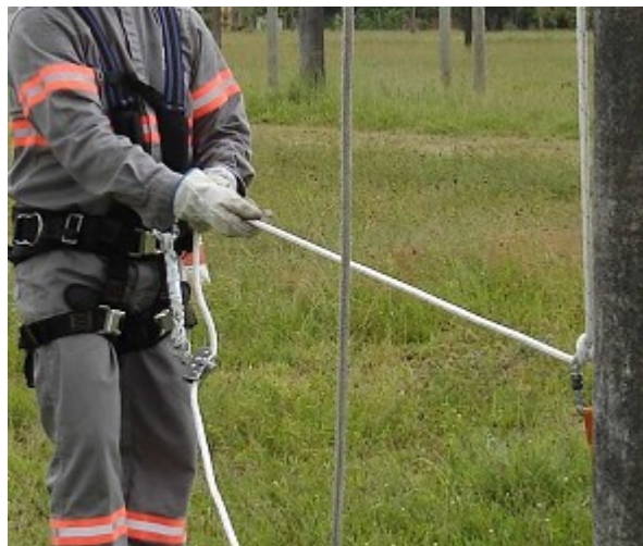
Figura 35 - Acionamento do nó de freio
