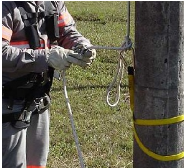
Figura 34 - Instalação do trava-quadras
